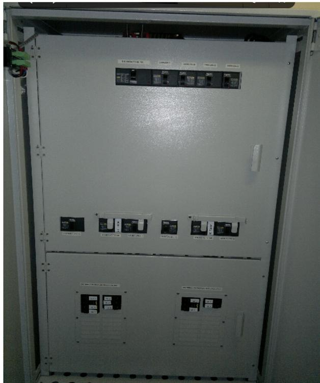
Toda la estructura del TDP, será previamente galvanizada en caliente con recubrimiento en pintura electrostática interna y externa de color gris cal 7035.
