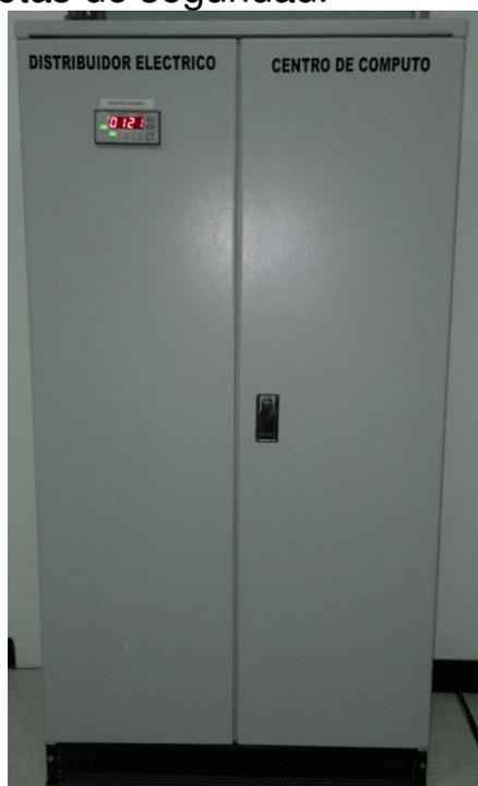
Incorpora TVSS, barras de alimentación primaria de las cuales se toman, mediante las debidas protecciones, En espacio, debidamente aislado, se instalan dos centros de carga que son alimentados desde el o los UPS con sus debidas protecciones.
